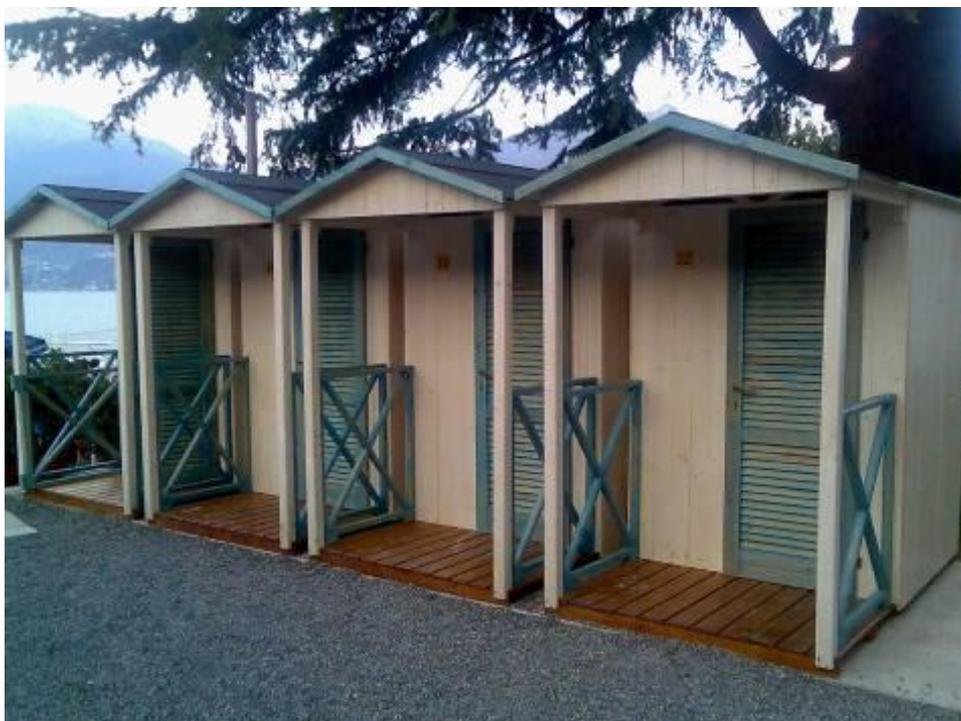
Cabine realizzate in perline di abete nordico da 20 mm o di pino impregnato in autoclave sempre di 20 mm di spessore (dipende dalla reperibilità sul mercato di legname stagionato) , intelaiate su montanti di pino da 70x70 mm. Tetto in multistrato ad incollaggio fenolico 15mm rivestito in guaina ardesiata. Porta a mezza persiana, con pannello inferiore, **con o senza** verandina anteriore.
