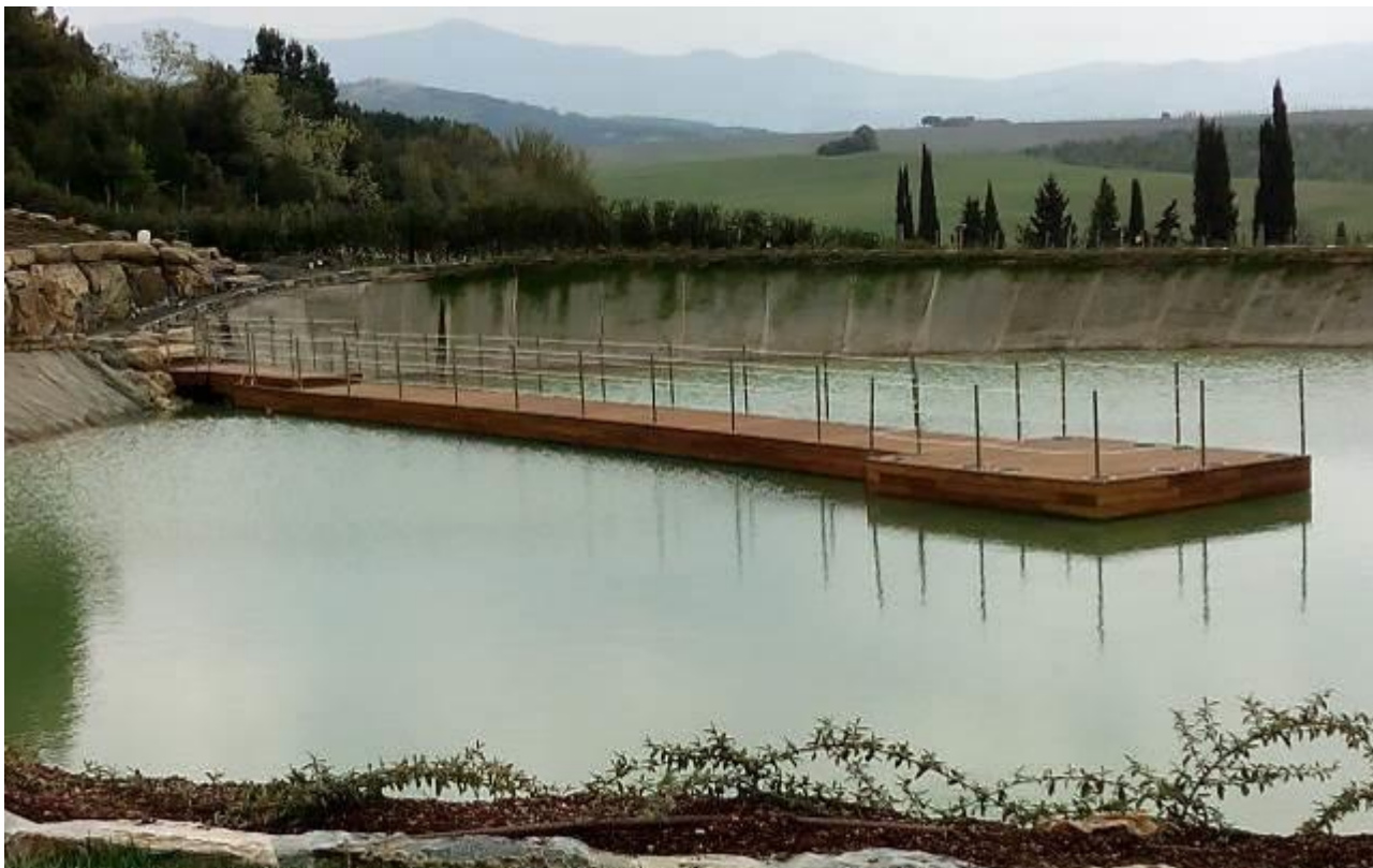
Pontile con rivestimento in legno "Teak"
