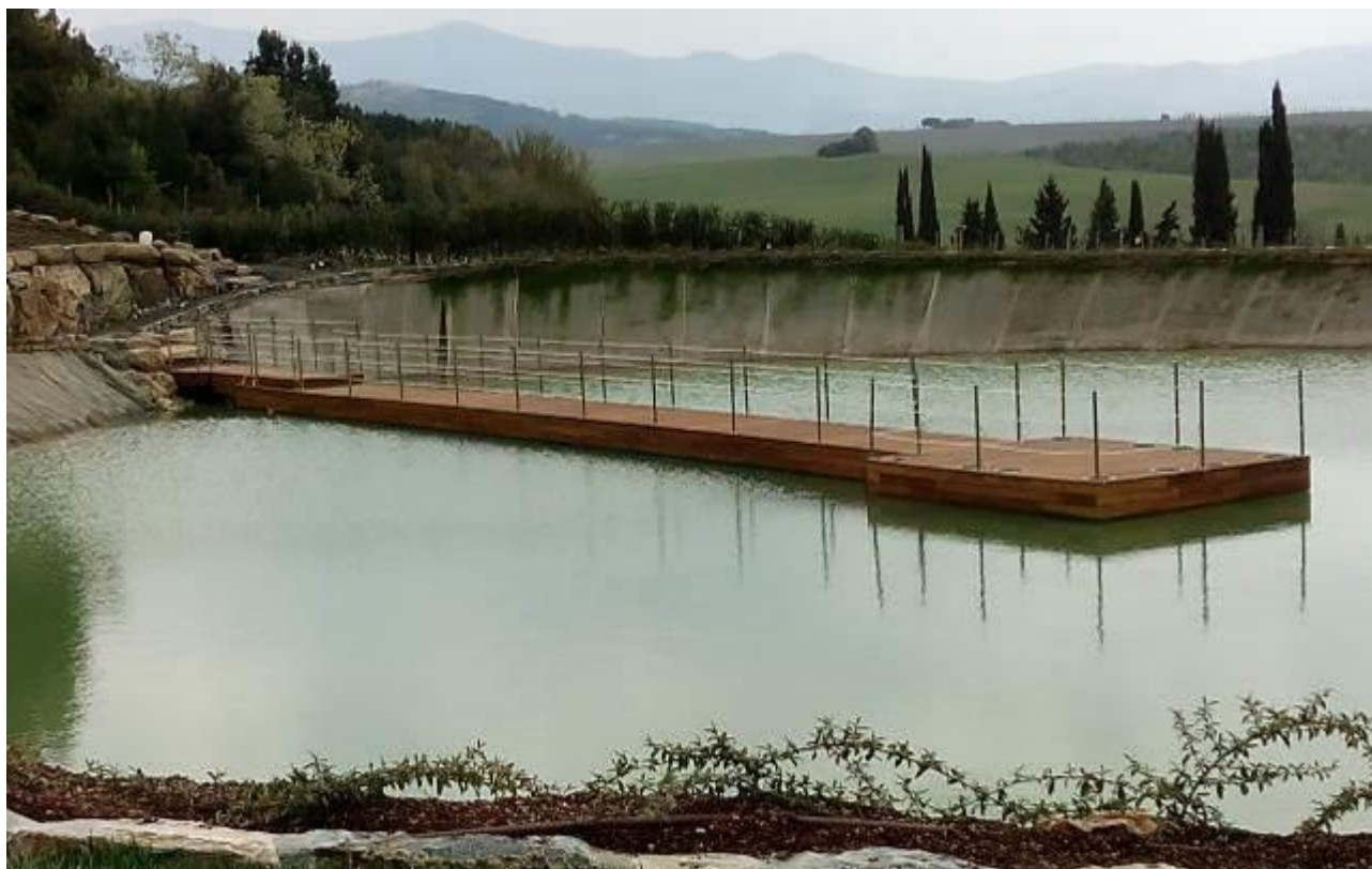
Pontile con rivestimento in legno "Teak"
