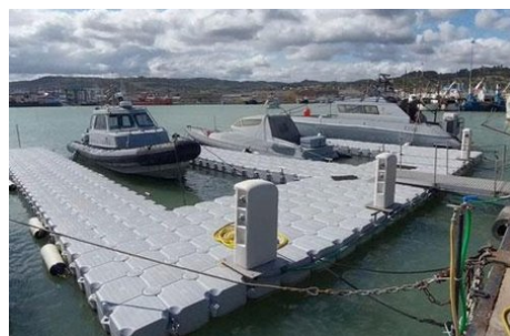
Pontile di ormeggio per la Guardia di Finanza Mooring dock for the Guardia di Finanza
