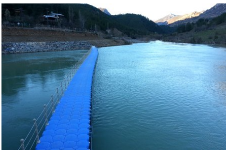
Pontile blu con ringhiera Blue dock with railing
