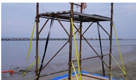
Piattaforma a supporto di un trabattello Platform supporting a scaffold tower
