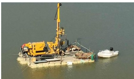
Piattaforma 500 x 550 cm con carotatrice (oltre 3.000 kg) 500 x 550 cm platform with drill rig (over 3,000 kg)
