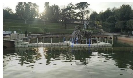
Restauro della Fontana del Forcone, Giardino di Boboli Restoration of the Fontana del Forcone, Boboli Garden
