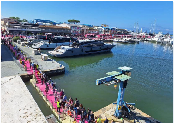
Passerella & Pontile Apribile Giro d'Italia Grande passerella galleggiante ad altissimo flusso pedonale con moquette rosa personalizzata allestita per il passaggio del Giro d'Italia. Dotata di sezione apribile per consentire il transito navale nel porto.
