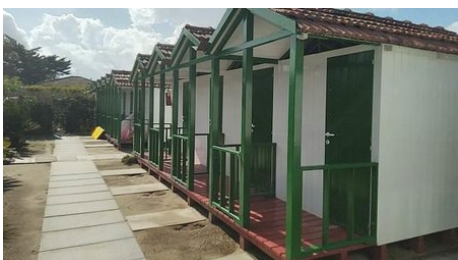
Schiera di cabine affiancate Row of side-by-side cabins
